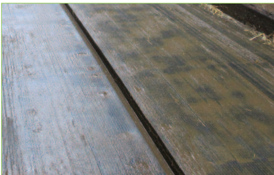
Photo 30 : Fixation des tapis correctement réalisée.
