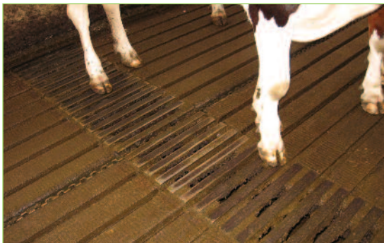
Photo 16 : Grille d'évacuation du lisier au milieu d'un couloir de circulation.
