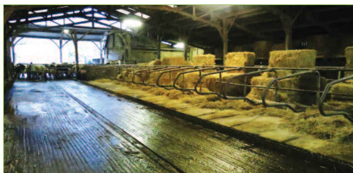
Photo 3 : La formation de flaques sur le couloir de circulation témoigne de la présence de contre-pentes.
