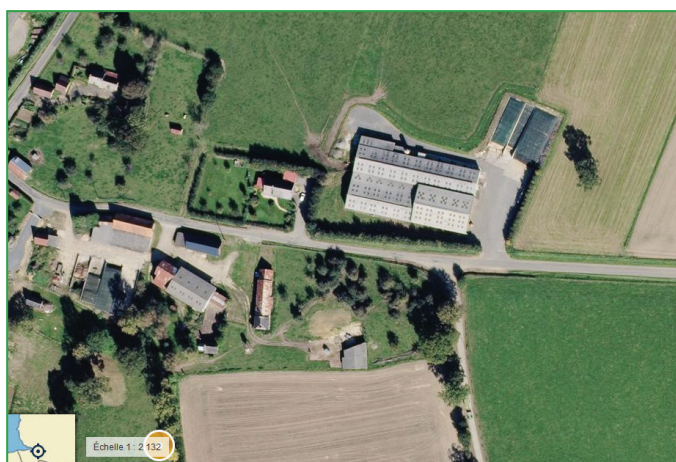
Photo 6 : Vue Géoportail d'un bâtiment pour vaches laitières
