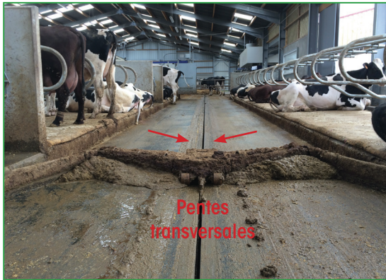
Photo 10 : Pentes transversales vers le rail du racleur d'un couloir de circulation
