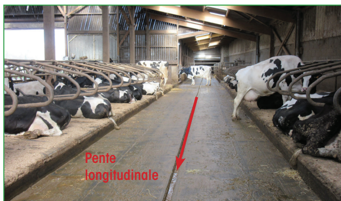
Photo 9 : Pente longitudinale d'un couloir de circulation
